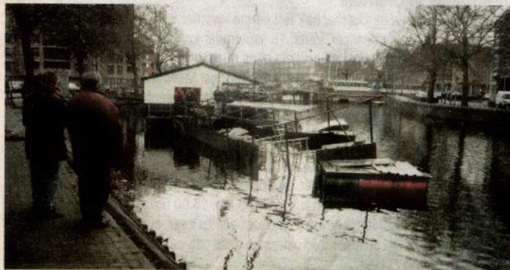
Door het opendraaien van een afsluiter verdween een deel van de ponton naar de bodem van de Rotte. Foto Rein Wolters
